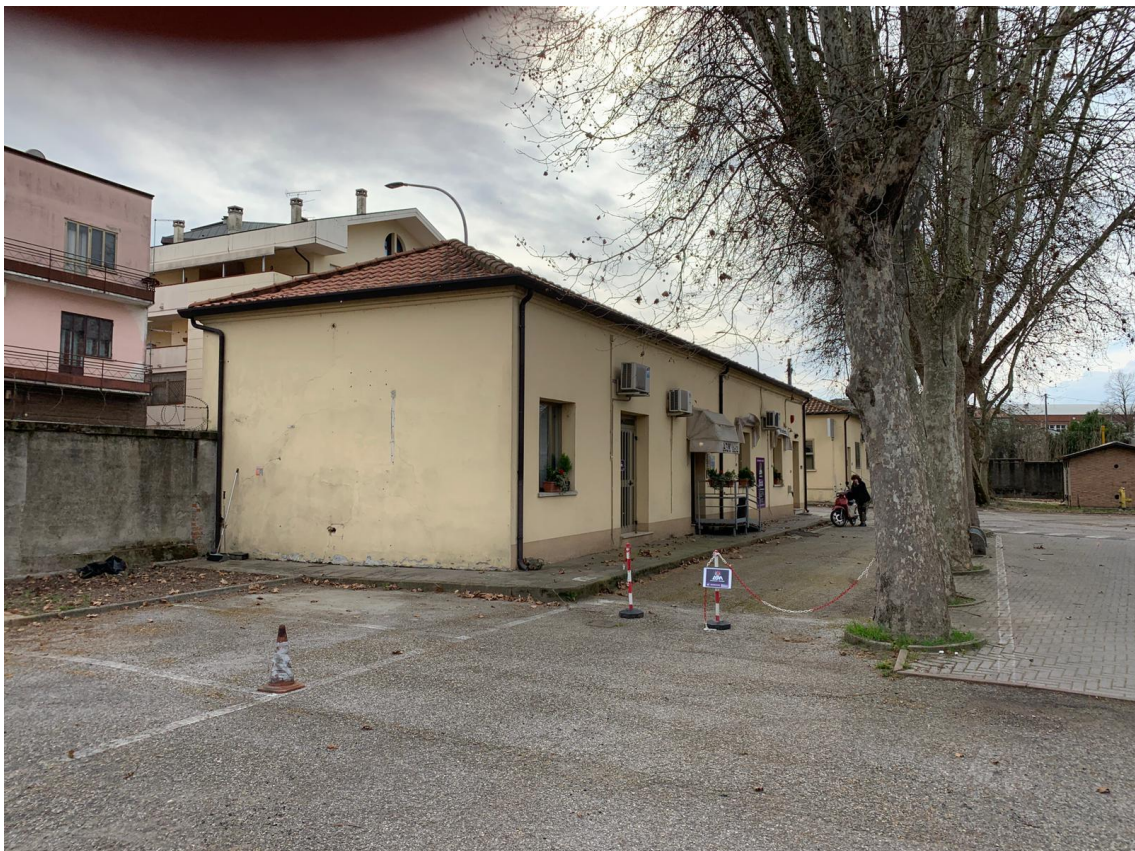
Foto 4 – edificio F – lato nord – est
