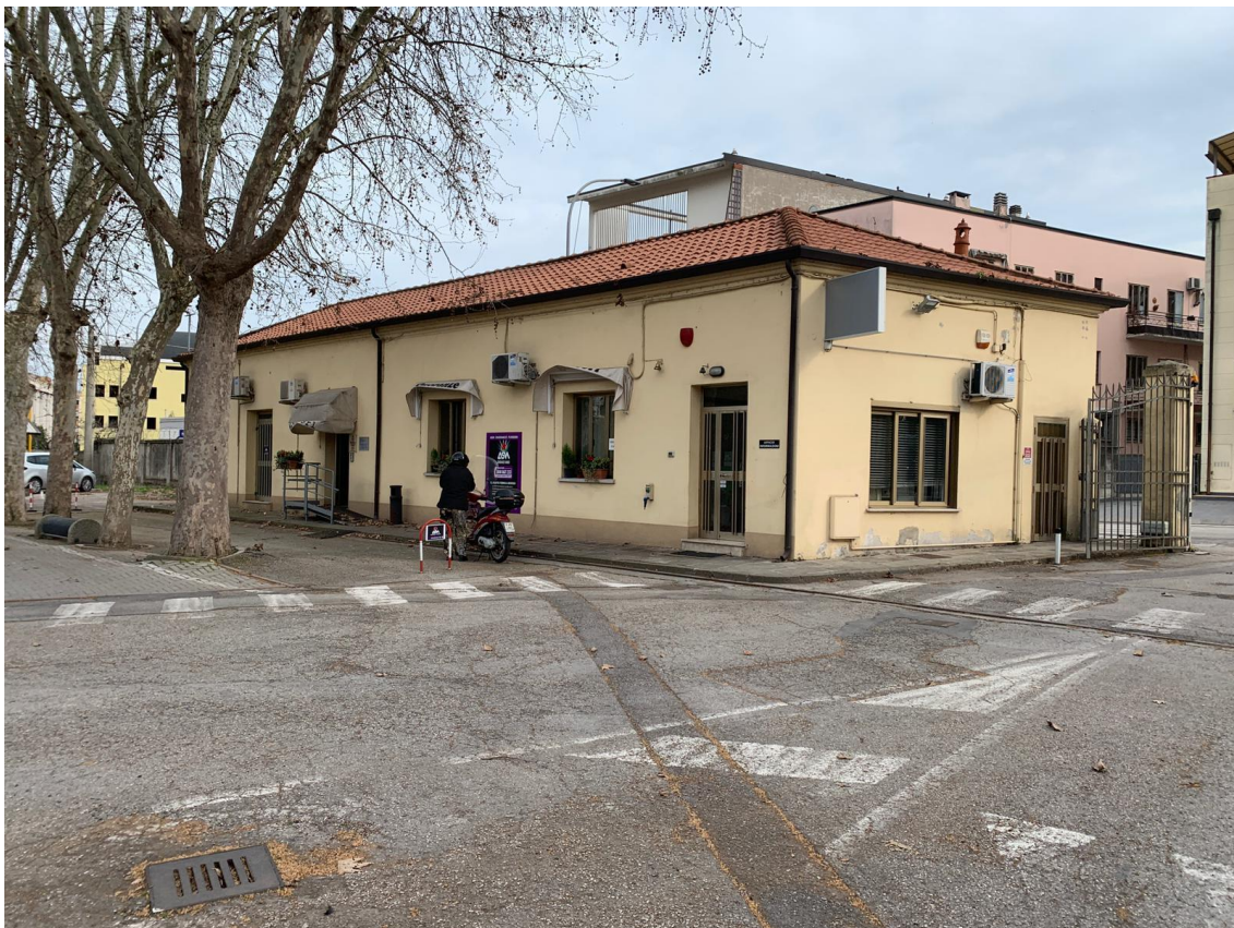
Foto 2 – edificio F – lato nord-ovest
