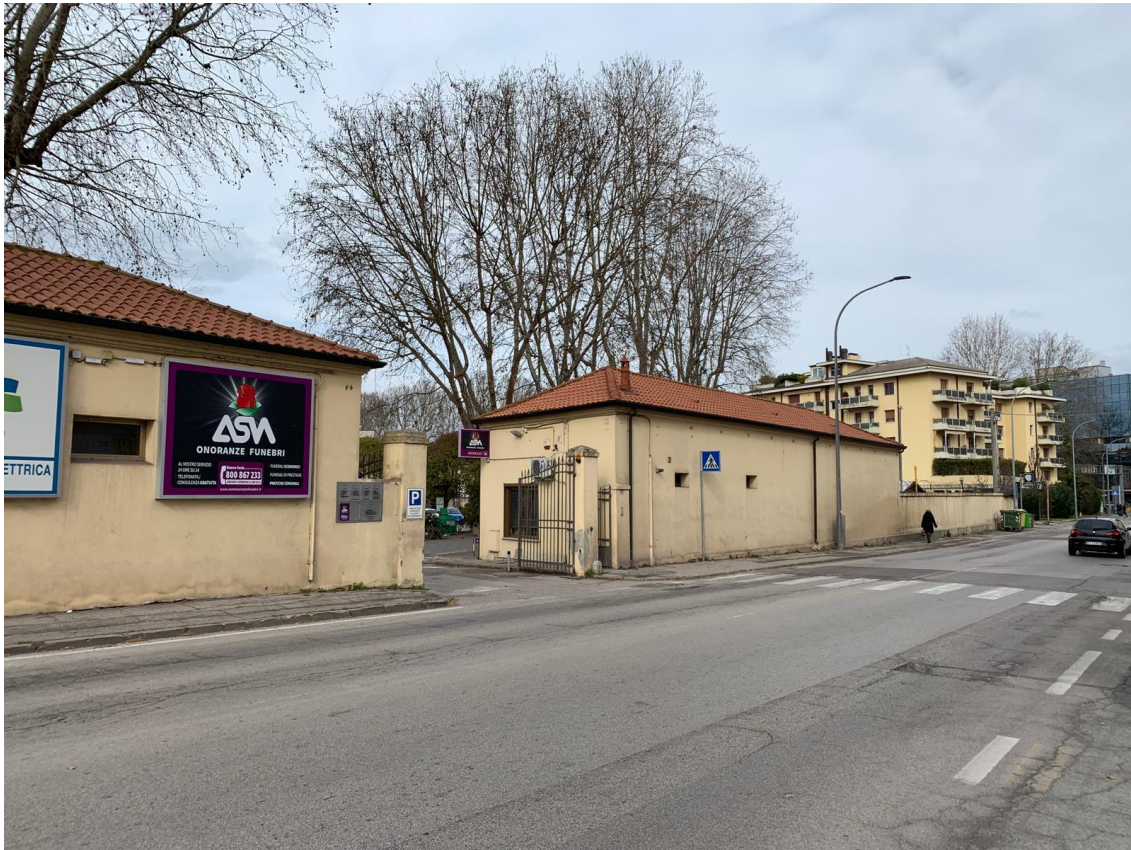
Foto 1 – edificio F – accesso all’area ASM da Via D. alighieri
